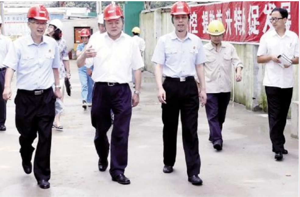
区人大常委会主任颜建平(左二)视察区法院再建的审判大楼工地
